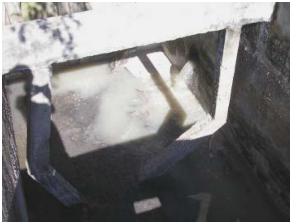
Figure 7.4 Incomplete Sedimentation Chamber in Barrio El Llano del Conejo
